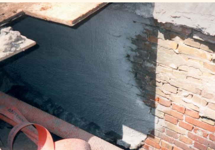
Vandtætning af muret fundament
