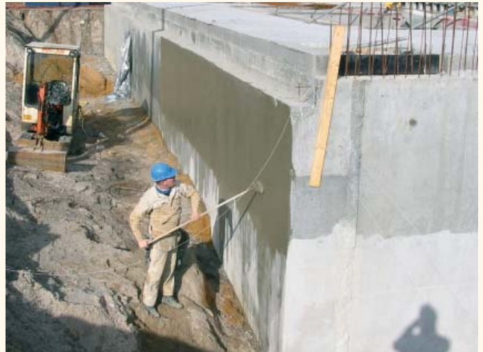
Vandtætning af fundament og kældervæg
